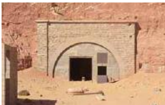
Entrée d'un tunnel sur la zone CEA de Reggane 17 novembre 2007. Photo Bruno Barrillot.
